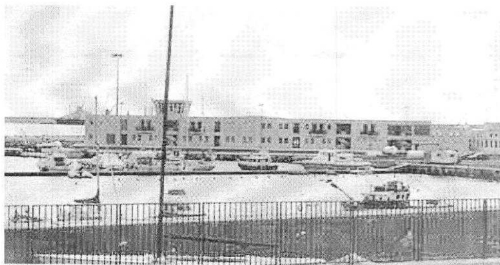
LA MESSA IN SICUREZZA DELLE OPERE MARITTIME SARÀ CURATA DAL GENIO CIVILE DI RAGUSA PER CONTO DEL COMUNE DI POZZALLO
